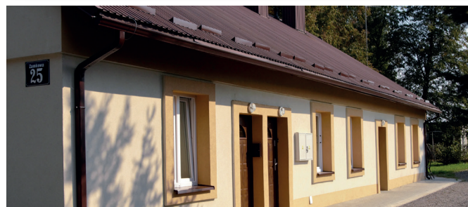
„CZWORAKI” PO TERMODERNIZACJI
