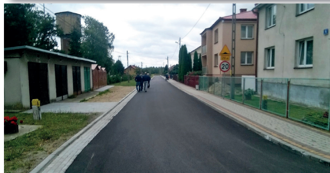
ULICA SIKORSKIEGO W SKOPANIU PO PRZEBUDOWIE
