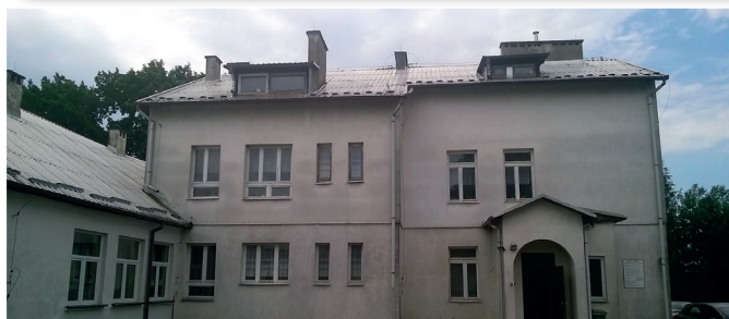
BUDYNEK ŚDS PRZED PRZEBUDOWĄ
