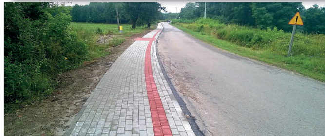
BUDOWA CHODNIKA PRZY UL. POPIELUSZKI W SKOPANIU
