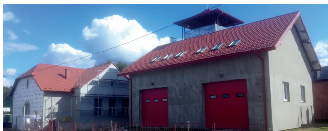
BUDOWA REMIZY OSP WRAZ Z MODERNIZACJĄ ŚWIETLICY W SKOPANIU
