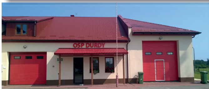
TERMOMODERNIZACJA REMIZY OSP W DURDACH
