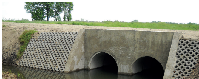
MODERNIZACJA PRZEPUSTU NA KANALE DYMITROWSKO - MŁODOCHOWSKIM
