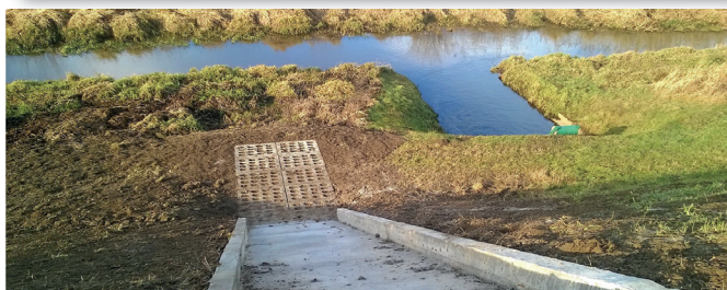
BUDOWA RYNNY ZRZUTOWEJ PRZY STANOWISKU POMPOWYM W BARANOWIE SANDOMIERSKIM
