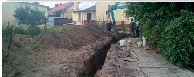
PRZEBUDOWA KANALIZACJI DESZCZOWEJ WRAZ Z MODERNIZACJĄ DROGI W BARANOWIE SANDOMIERSKIM
