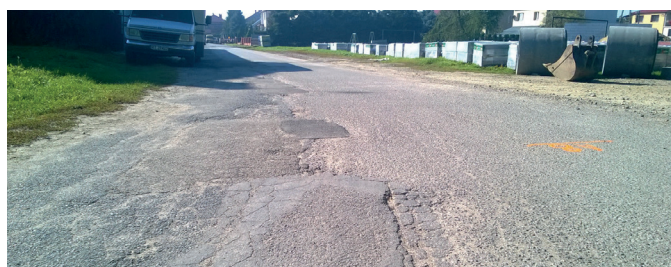
UL. ZAMKOWA OSIEDLE W BARANOWIE SANDOMIERSKIM PRZED PRZEBUDOWĄ
