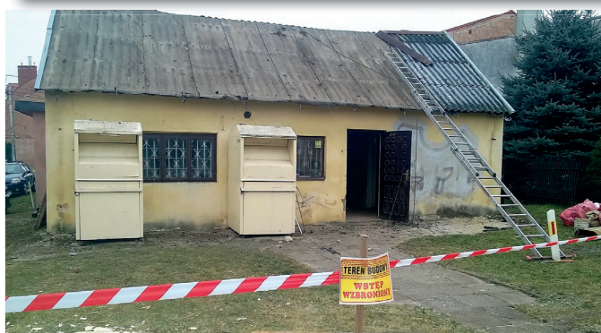
ROZBIÓRKA PUSTOSTANÓW W BARANOWIE SANDOMIERSKIM
