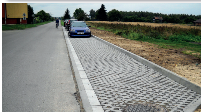
BUDOWA MIEJSC POSTOJOWYCH PRZY UL. MIELECKIEJ W SKOPANIU
