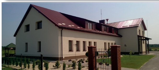
CENTRUM REKREACJI W DURDACH
