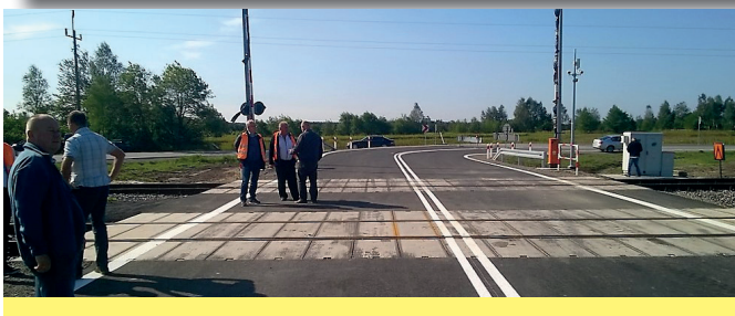
ZMODERNIZOWANY PRZEJAZD KOLEJOWO - DROGOWY W KNAPACH
