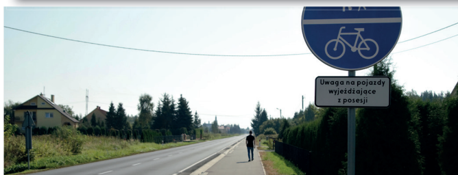
BUDOWA ŚCIEŻKI PIESZO - ROWEROWEJ PRZY DW872 W WOLI BARANOWSKIEJ - ETAP I
