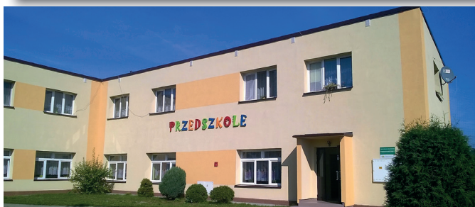
PRZEDSZKOLE W WOLI BARANOWSKIEJ PO MODERNIZACJI
