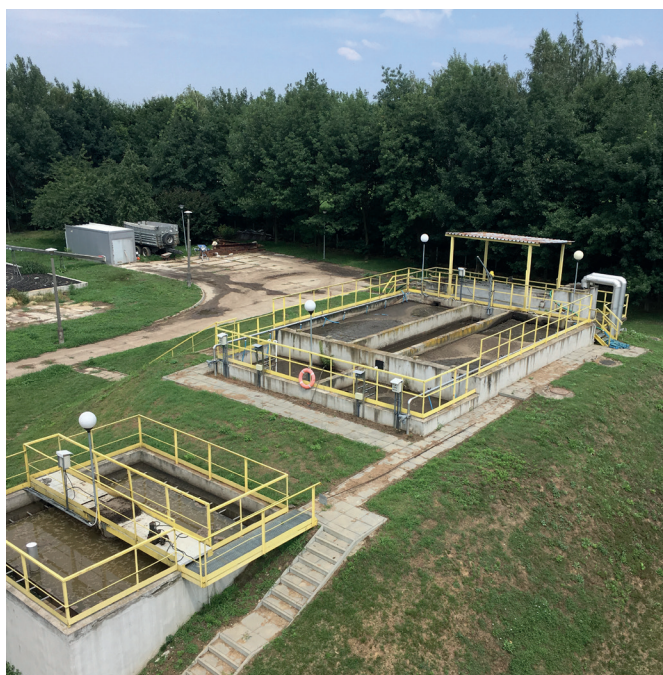
STARY BŁOK OCZYSZCZALNI ŚCIEKÓW DO KOMPLEKSOWEJ PRZEBUDOWY
