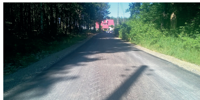
NOWE DROGI ASFALTOWE W GMINIE
