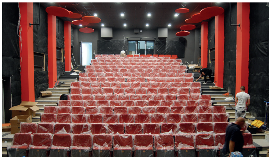
OSTATNIE DNI PRAC NAD WYGLĄDEM NOWEJ WIDOWNI MGOK-U
