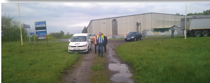
GRUNTOWA DROGA W KNAPACH PRZED BUDOWĄ OBWODNICY
