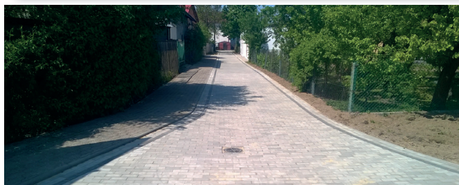
PRZEBUDOWA ULICY „DO WIEŻY” W BARANOWIE SANDOMIERSKIM
