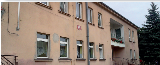
PRZEDSZKOLE W SKOPANIU PRZED ROZPOCZĘCIEM INWESTYCJI
