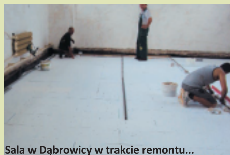
Sala w Dąbrowicy w trakcie remontu...
